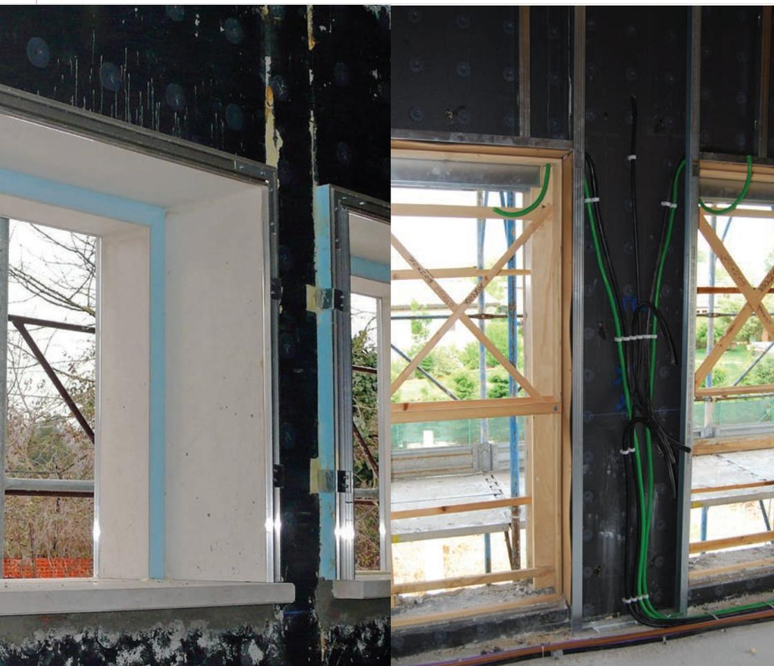
Falso telaio prefabbricato da montare prima del getto
