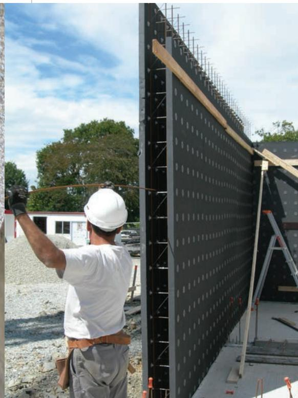
In questo caso è conveniente infilare prima un tubo di plastica (del tipo impiegato per gli impianti elettrici) di adeguata sezione; si infila poi il ferro nel tubo e si sfilava il tubo.
