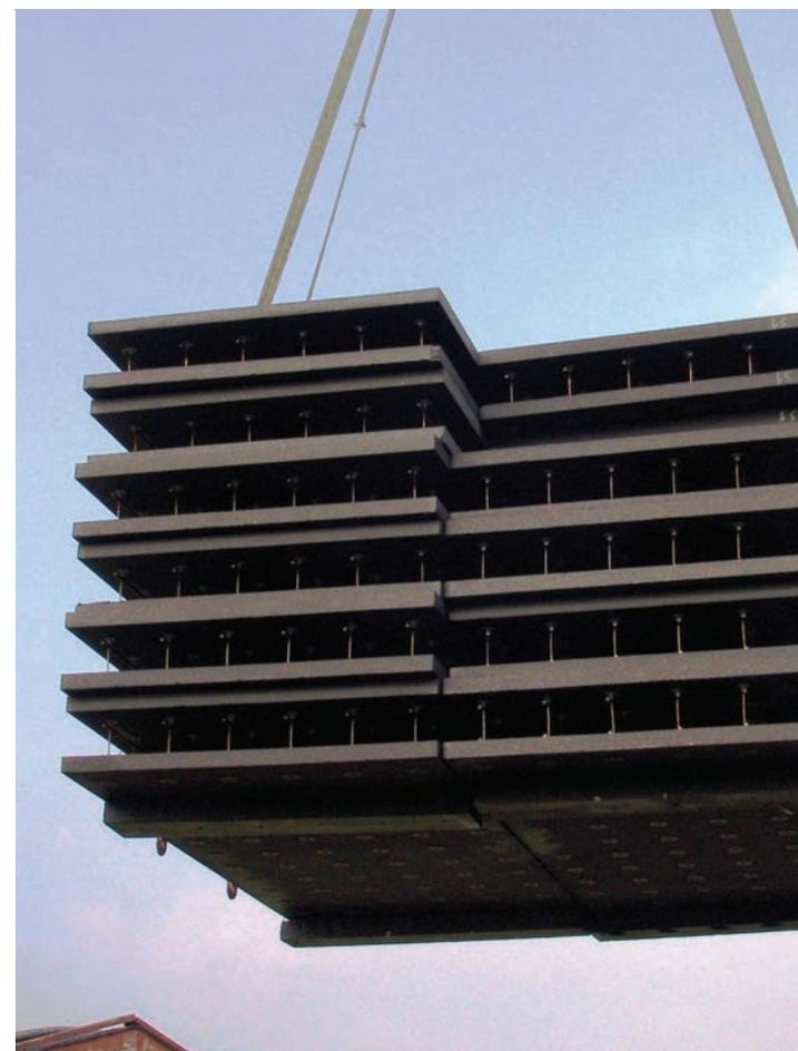
La posa in opera degli **elementi cassero PLASTBAU®-3** avviene manualmente e viene facilitata da profilati ad "U" in lamiera, previamente fissati sulla soletta, in corrispondenza della lastra interna del pannello. Lo stesso profilato, utilizzato sul bordo superiore della lastra, servirà a mantenere il perfetto allineamento dei pannelli.
